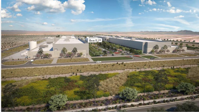
Meta Datacenter – Mesa, AZ
